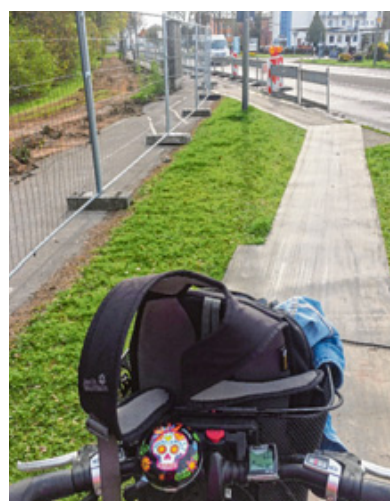
Für Radler in diesen Tagen nur mit Mühen passierbar: die Baustelle an der Dillinger Ortseinfahrt in der Donauwörther Straße. Foto: Bronnhuber
